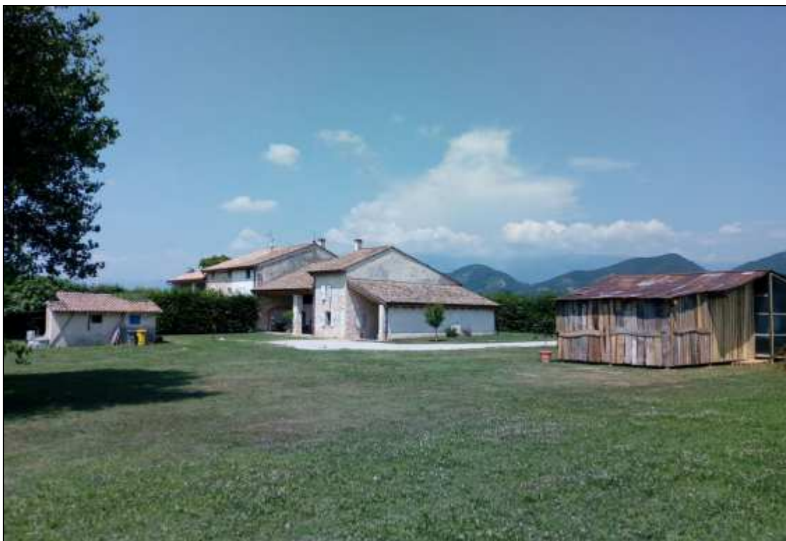
Fabbricato A - Vista da sud est
