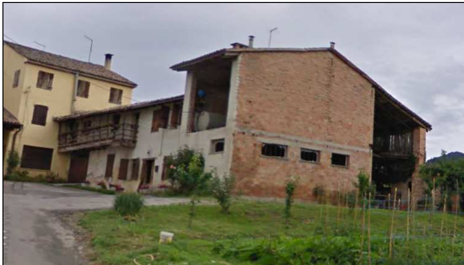
Vista da sud-sudovest dell'annesso oggetto di cambio (tratta da Street View).
