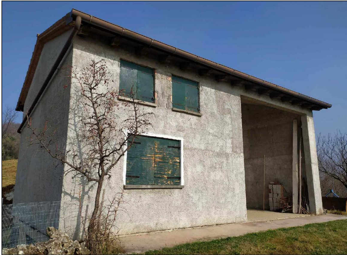
Vista da sud dell'annesso oggetto di cambio – stato di fatto.
