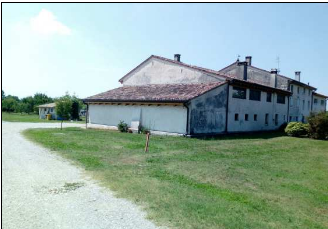
Fabbricato A - Vista nord est
