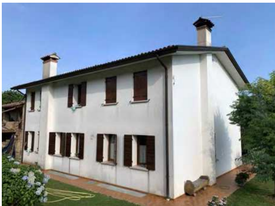
Vista da nord dell'annesso oggetto di cambio – stato di fatto.
