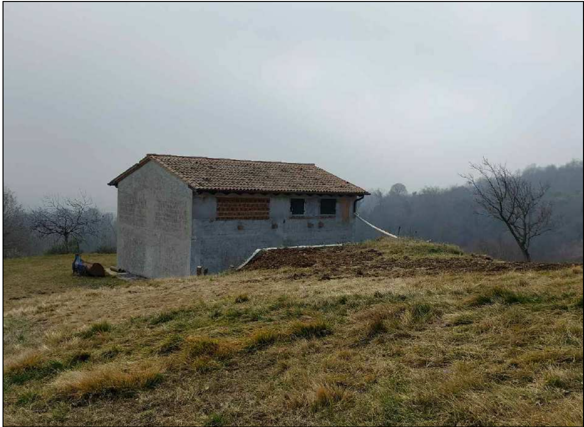
Vista da nord-est dell'annesso oggetto di cambio – stato di fatto.
