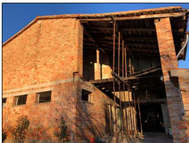
Vista da sud dell'annesso oggetto di cambio (tratta Documentazione Fotografica)
