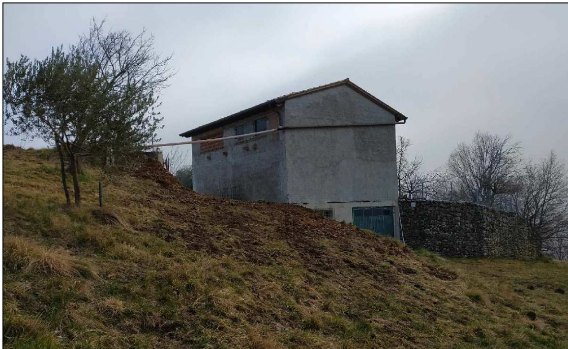
Vista da ovest dell'annesso oggetto di cambio – stato di fatto.
