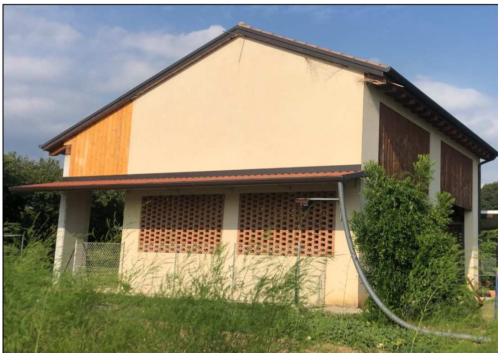
Vista da ovest dell'annesso oggetto di cambio
