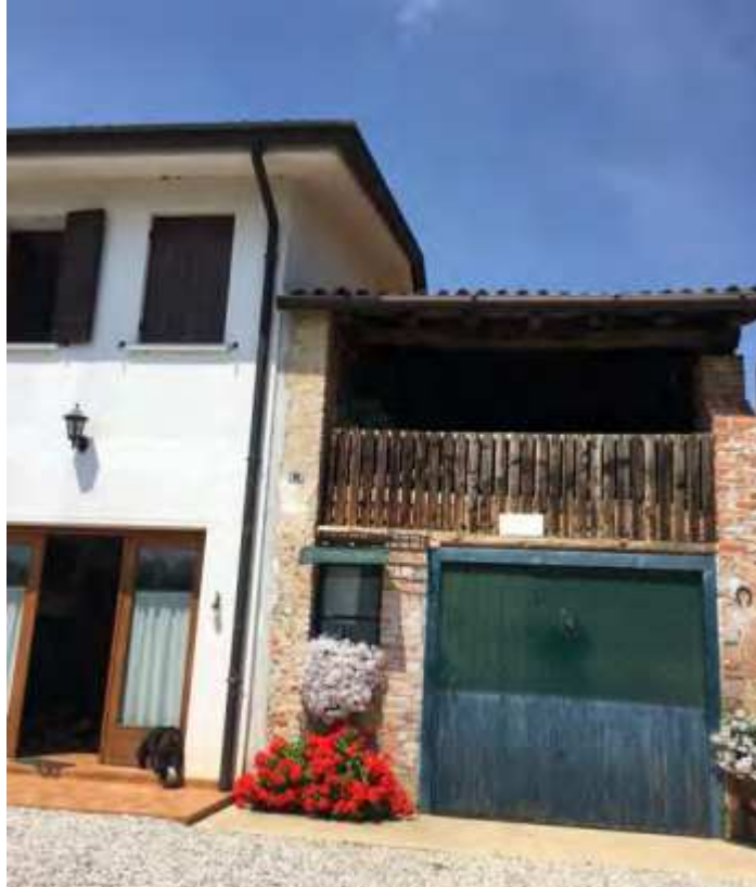
Vista da sud dell'annesso oggetto di cambio – stato di fatto.
